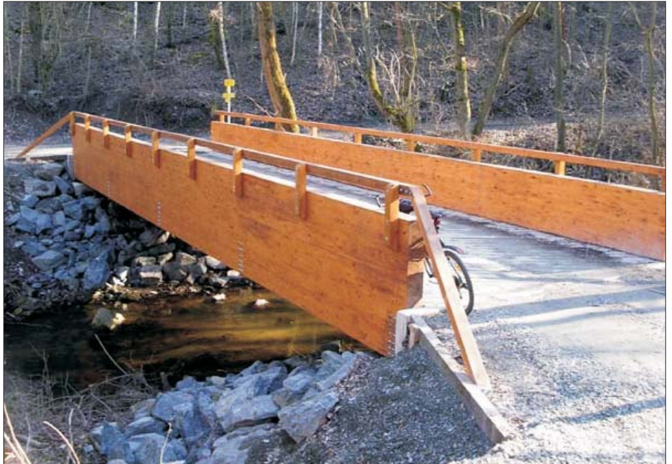
Cyklisty a turisty jistě potěší nová lávka – mostek v údolí Bobravy. Objekt se nalézá před železničným lome (bráno po proudu řeky) a usměrňuje pohyb chatařů a turistů mimo hlavní pracoviště lomu. Jedná se o dřevěnou lepenou konstrukci. Parametry mostu: délka 16 m, šířka 4,5 m, nosnost 2,5 t. Dřevěné konstrukce vhodně zapadají do krajiny a jsou ekonomicky méně náročné a ekologické.
