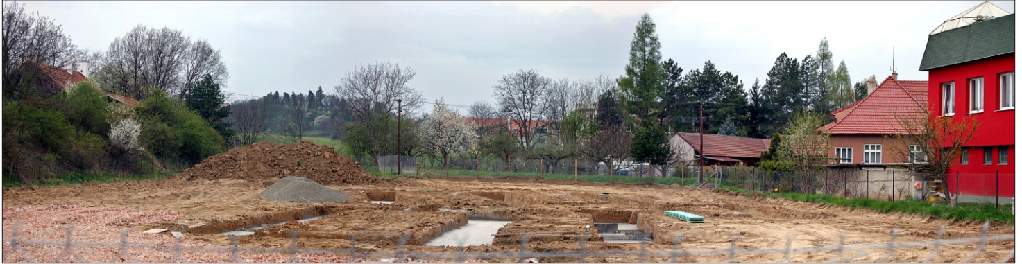
Výstavba nové mateřské školy ve Střelících byla zahájena.
