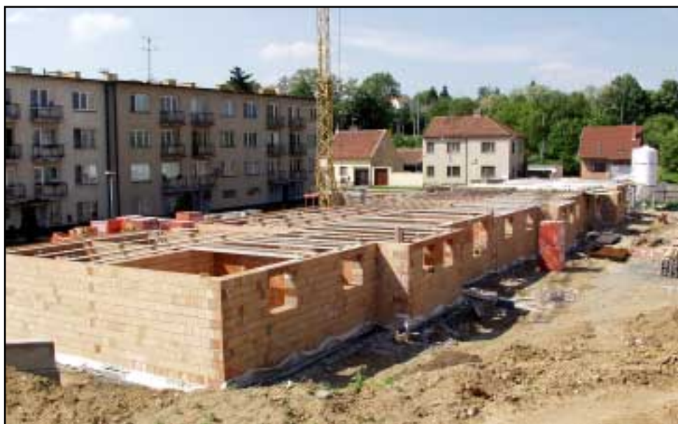
Stavba bytového domu v ul. Ant. Smutného je již v plném proudu.
