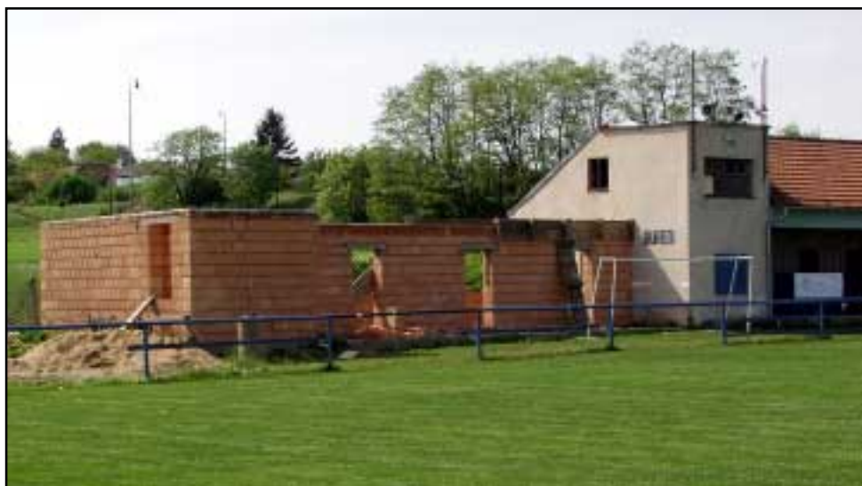
Stavba kabin na fotbalovém hřišti TJ Sokola Střelice.
