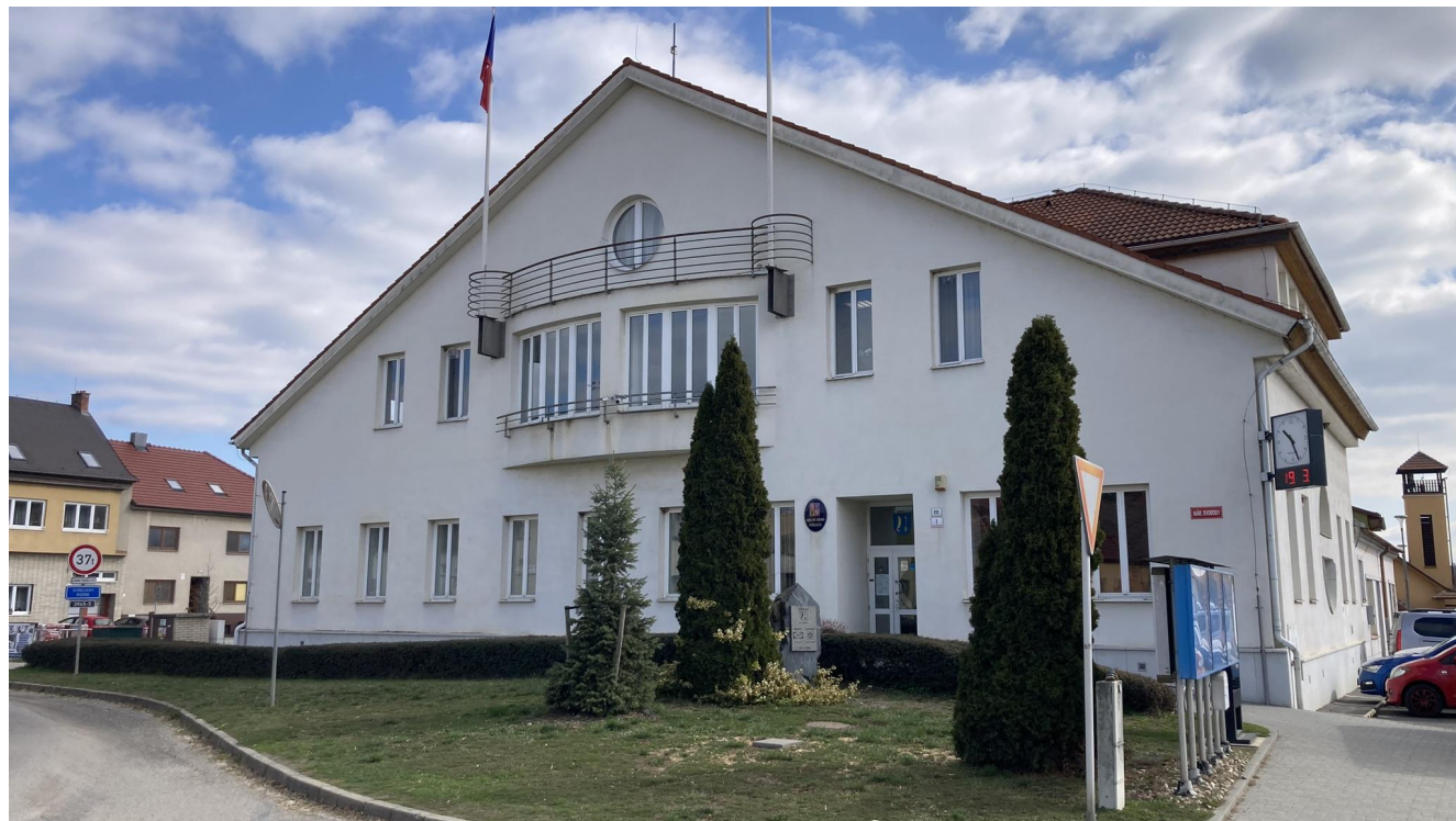
Předprostor obecního úřadu s nově vysazeným vánočním stromem a s již nefunkční okrasnou výsadbou zastihující nástup do úřadu.
