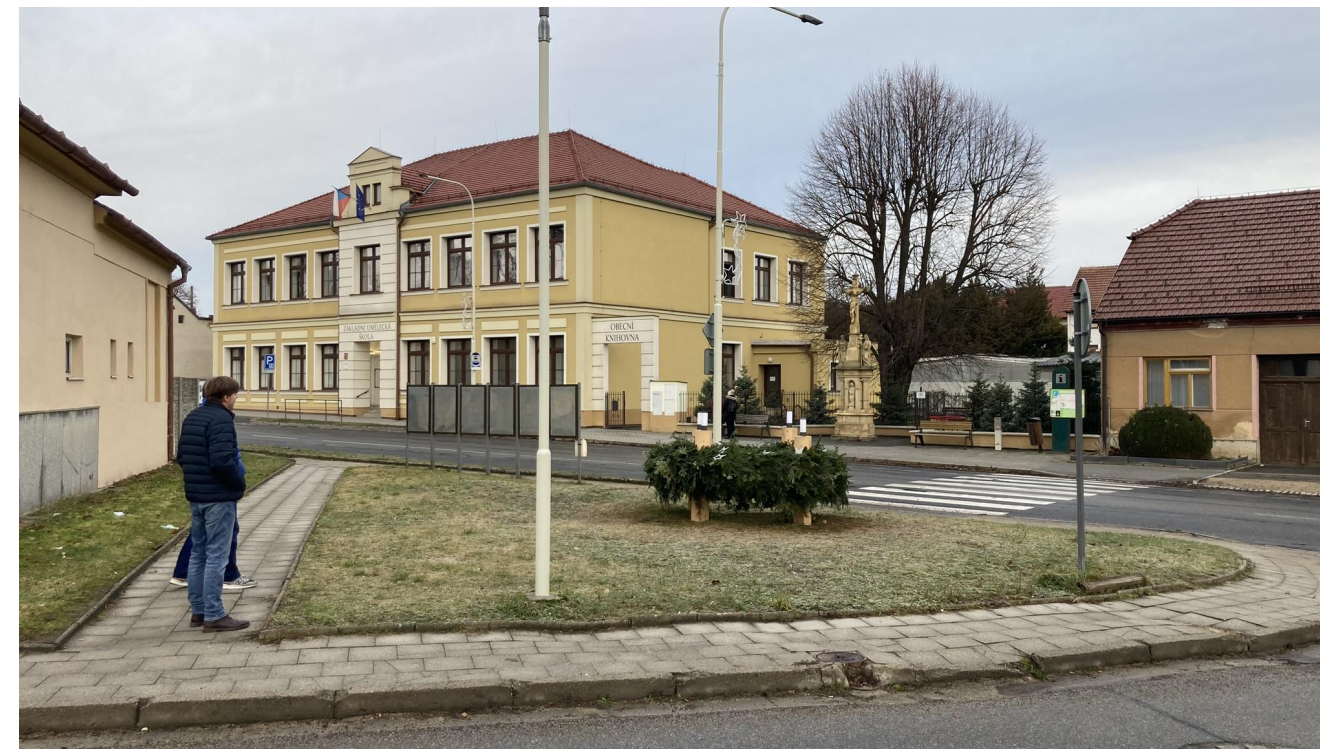
Nárožní parcela vedle obecního hostince s travnatou plochou a chodníky zajišťující pěší napojení centrálního prostoru náměstí se západní částí obce.
