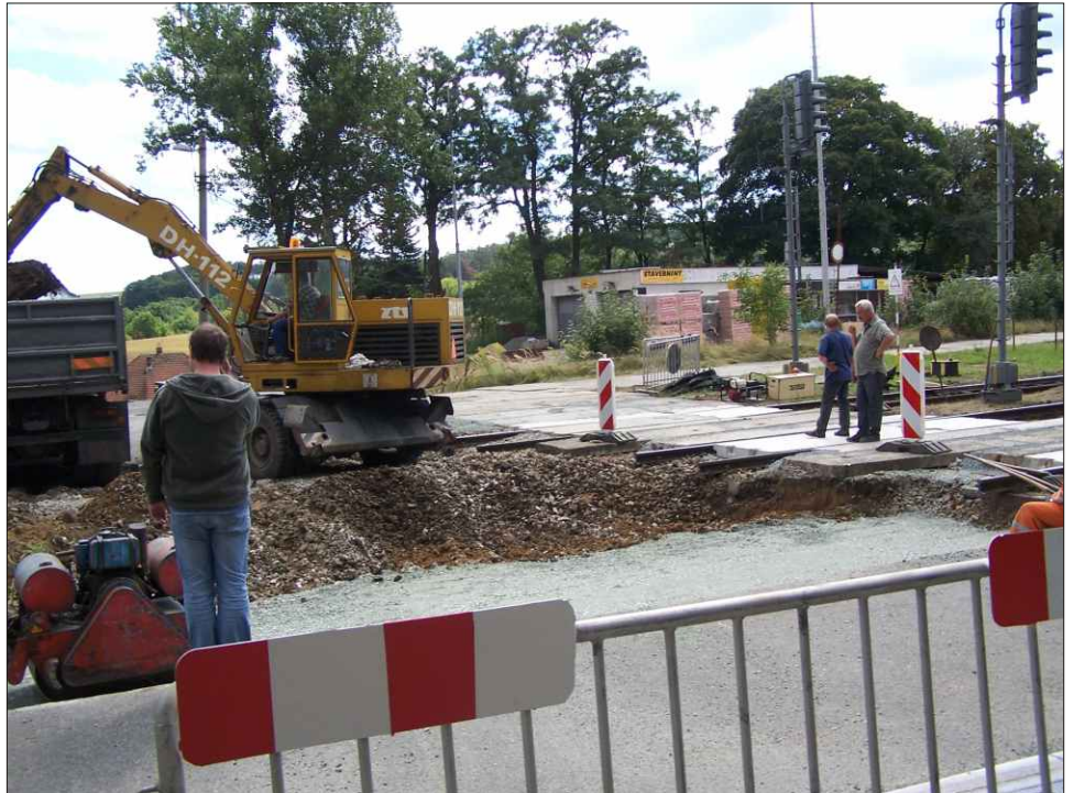
Oprava železničního přejezdu k nádraží (snímek ze zahájení prací na opravě v neděli 24.8.2008).
